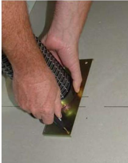
4. Führen Sie den Ablassschlauch durch den unteren Teil der Maschine, und legen Sie die Maschine in ihre Position. Mit den Wandbefestigungsschrauben anpassen. Der gewünschte Abstand kann durch Einstellen der 1 Mutter und 1 Unterlegscheibe an jedem Bolzen erreicht werden. Sobald dies geschehen ist, werden die restlichen 1 Scheibe und 1 Nuss aufgelegt. Befestigen Sie die Maschine, indem Sie die Muttern festziehen.
